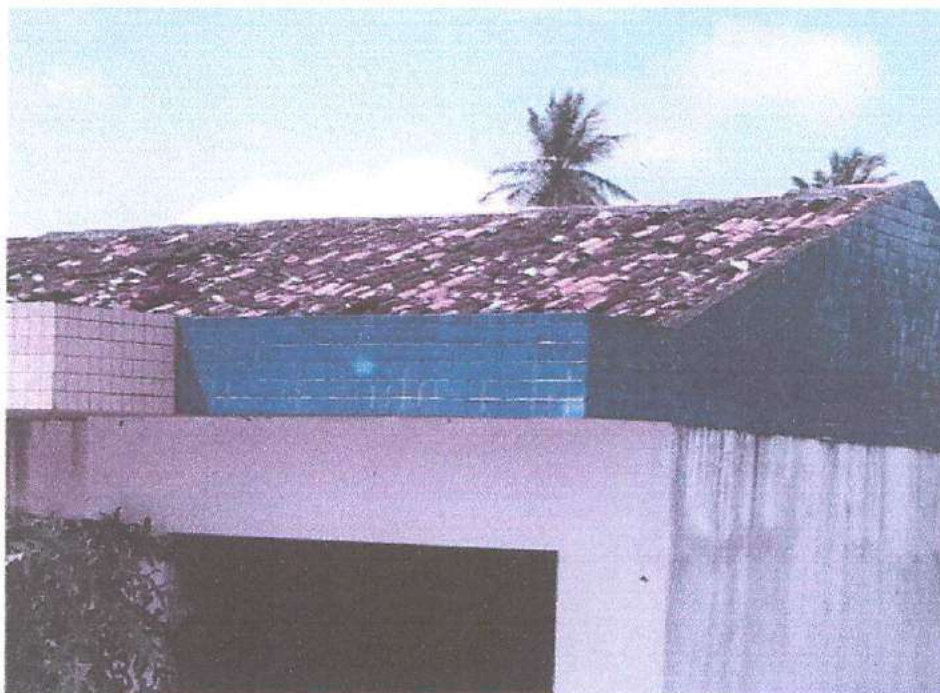
Foto 13 – Telhado deteriorado
