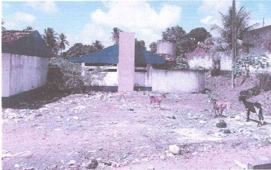
Foto 5 – Vista frontal da Creche
