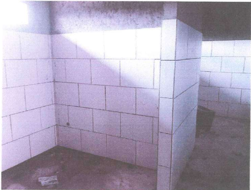
Foto 8 – Acabamento interno (Revestimento cerâmico)
