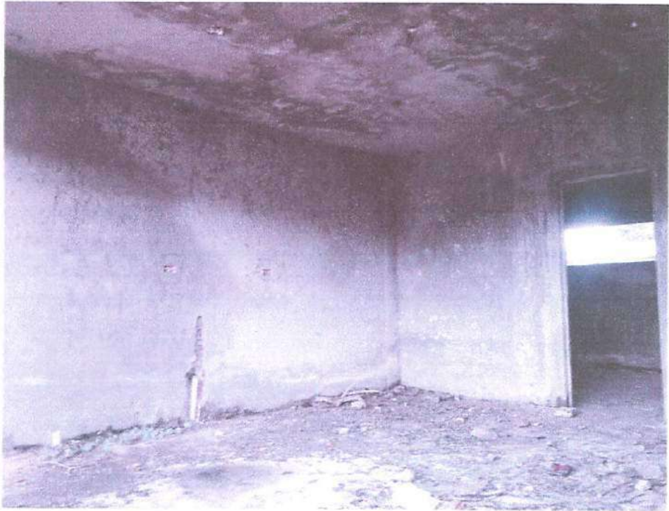
Foto 7 – Acabamento interno (Reboco)
