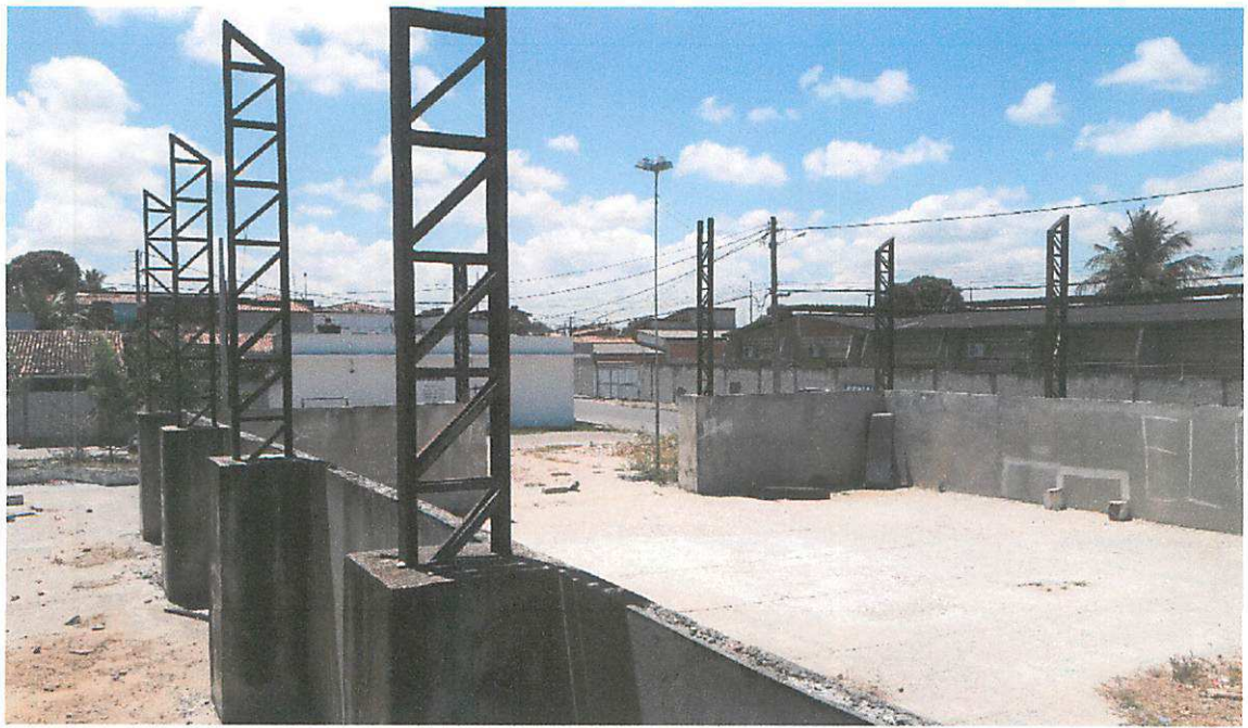
Imagem 06: Estrutura existente na Praça Juscelino Kubitchek que será revitalizada para a implantação das quadras de beach tennis .
