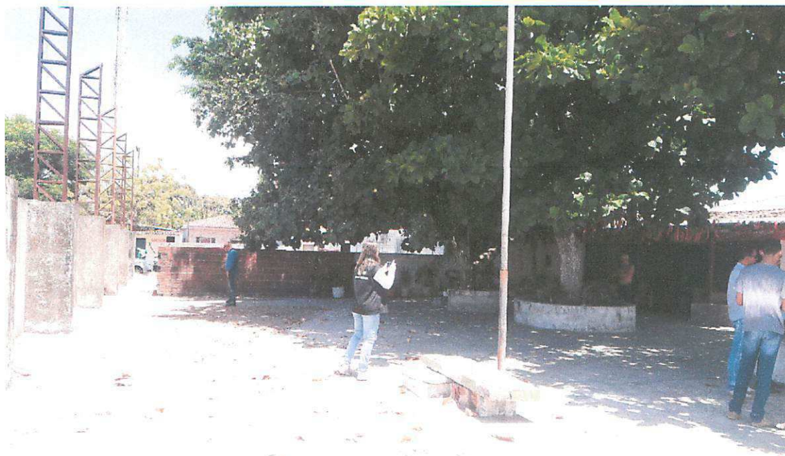
Imagem 01: Árvore que será removida em virtude dos danos causados por sua raiz às edificações vizinhas. Será construída no local área de convivência com bancos e mesas.
