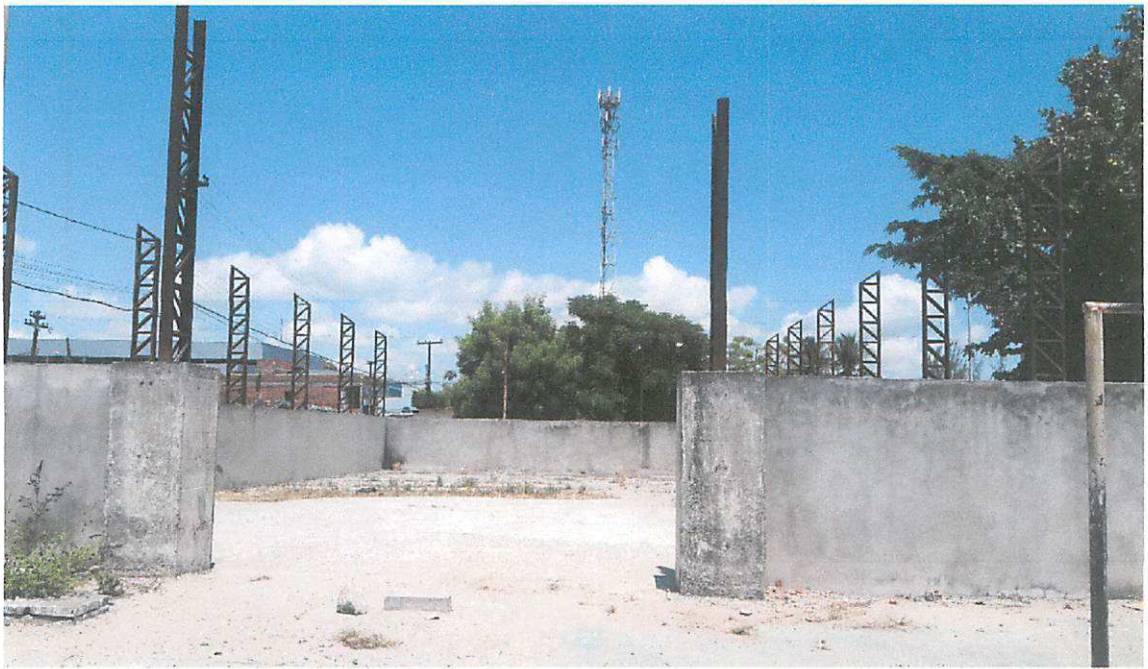
Imagem 04: Estrutura existente que será revitalizada para implantação das quadras de beach tennis .
