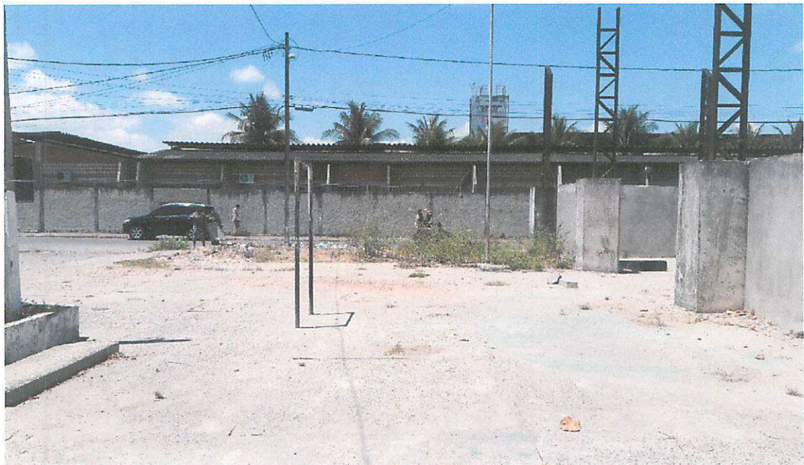
Imagem 03: Piso danificado e falta de iluminação adequada. No local será construído um playground .
