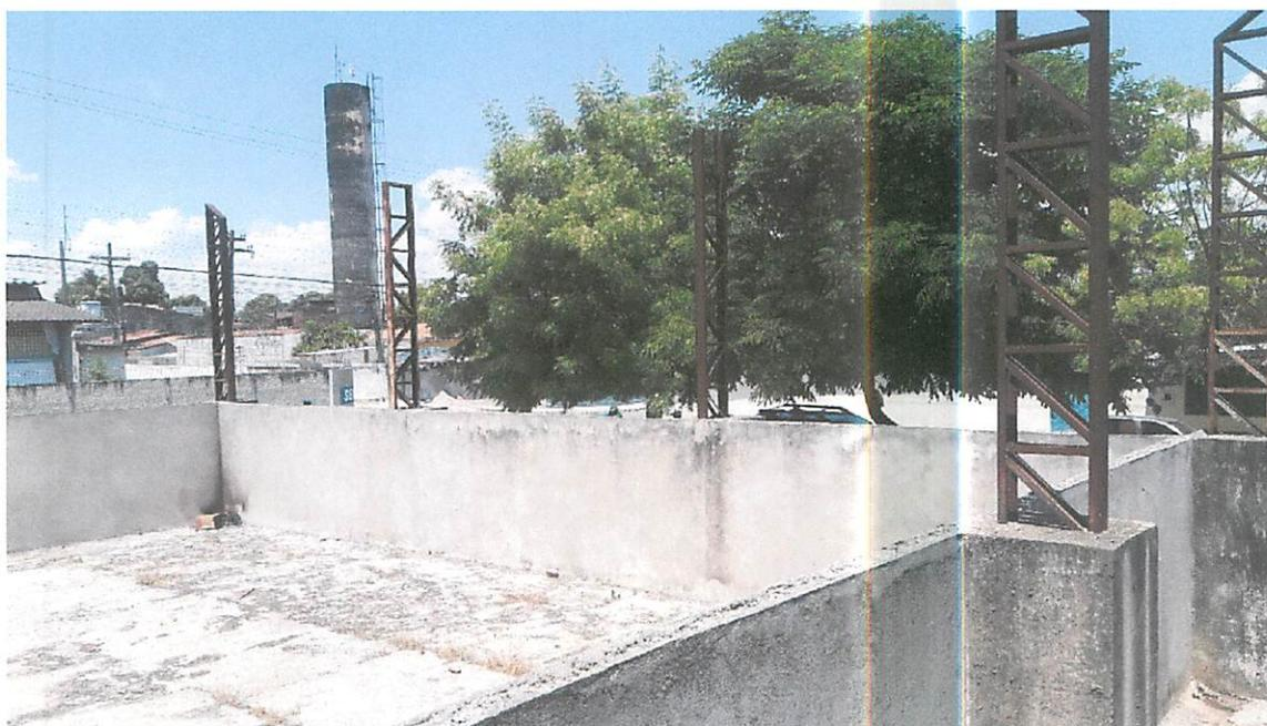
Imagem 05: Estrutura metálica será recuperada em razão da oxidação decorrente da ação temporal. A mureta será rebaixada para a altura de 1,10m.
