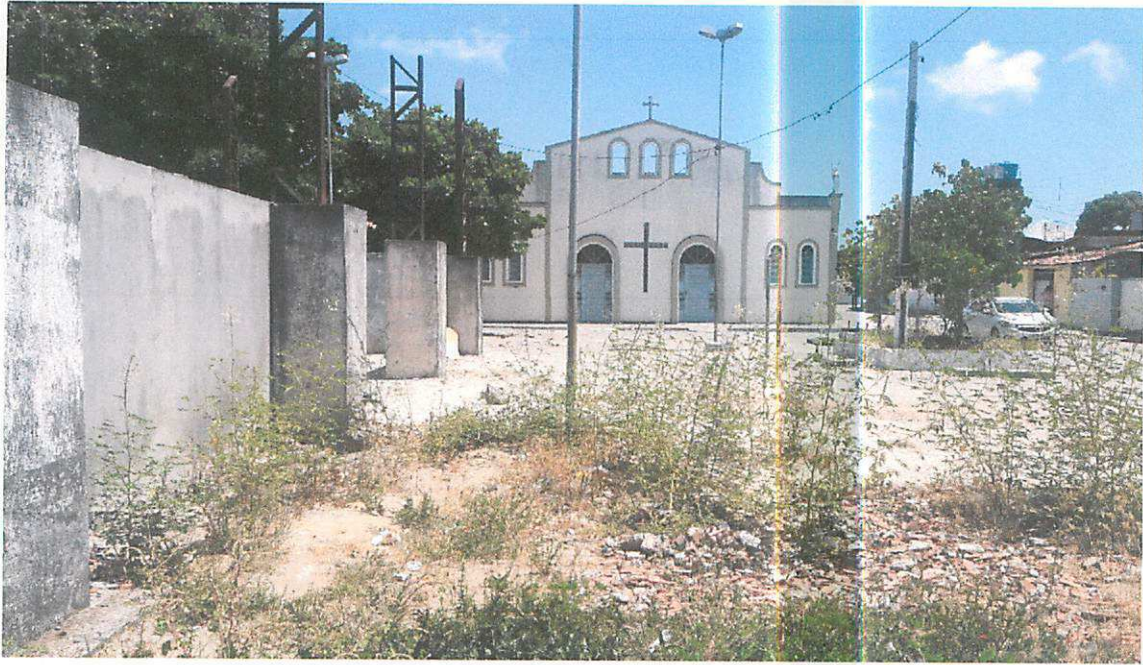
Imagem 08: Piso deteriorado que será substituído conforme indicações no projeto arquitetônico.
