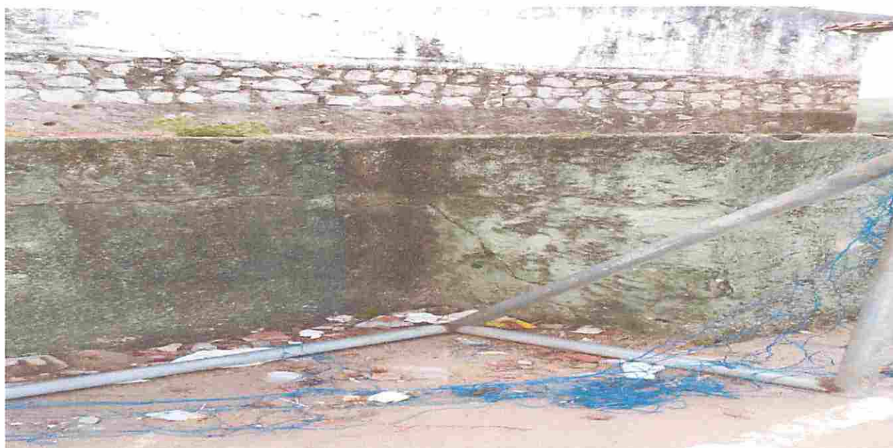
MURETA DE CONTENÇÃO
