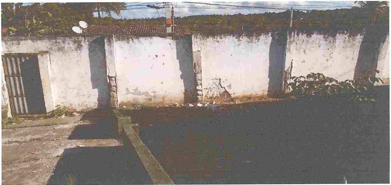
MURO DE CONTORNO LADO ESQUERDO
