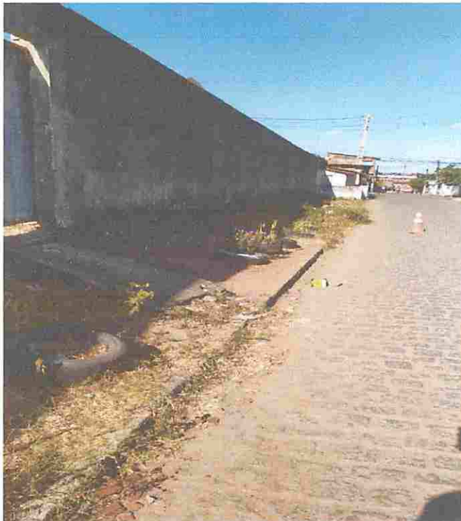
CALÇADA DE ACESSO À QUADRA
