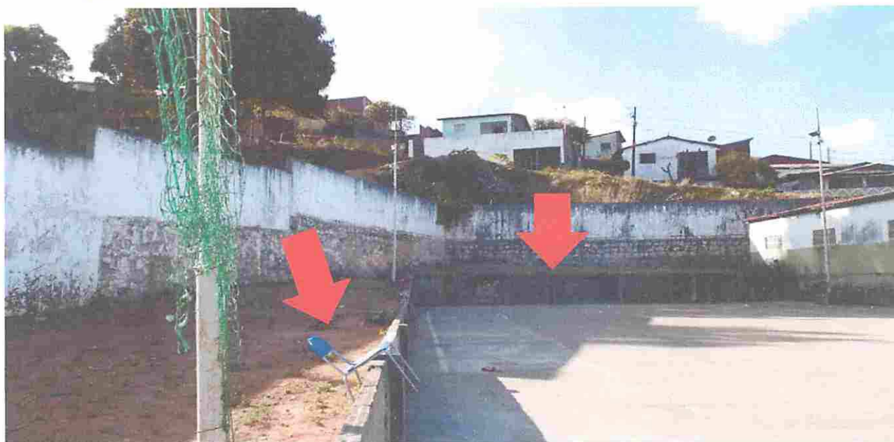
ESPAÇO A SER COLOCADO PISO INTERTRAVADO
