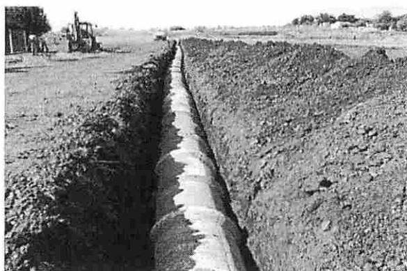
Figura 4. Instalação de galeria
