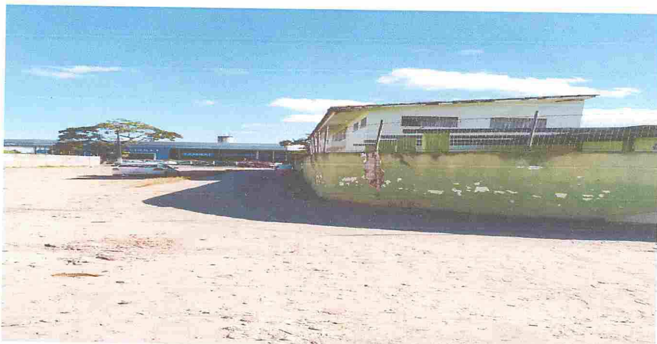
FACHADA LATERAL ESQUERDA
