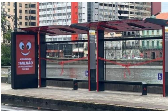
Modelo - Estrutura em aço galvanizado revestido em chapa de acm, cobertura em policarbonato com estrutura de aço e painel de publicidade instalado ao lado tamanho 3,00m.
