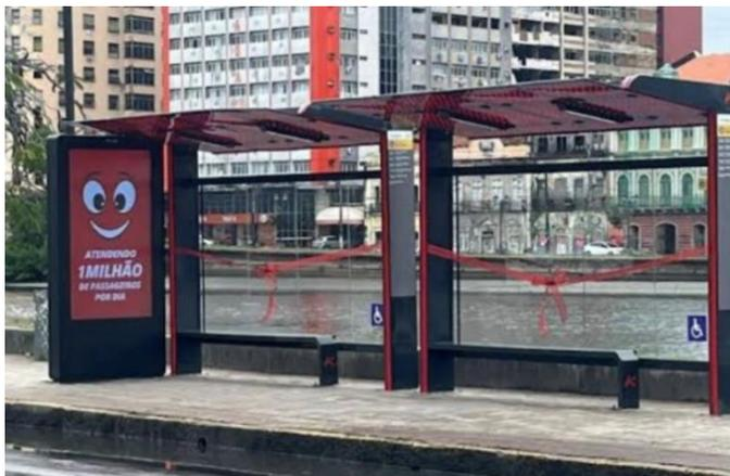
**Modelo** - Estrutura em aço galvanizado revestido em chapa de acm, cobertura em policarbonato com estrutura de aço e painel de publicidade instalado ao lado tamanho 3,00m.
